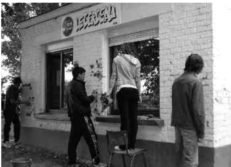
Rafraîchissement de la façade de la MJ "Le Cerceau" et de l'AMO "La Croisée"
