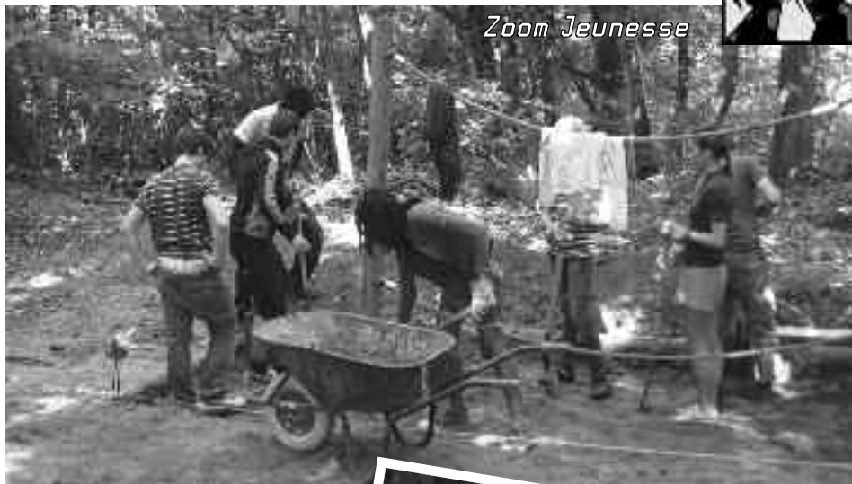
Sécurisation de jeux pour enfants dans le parc du Domaine ONE de La Hulpe
